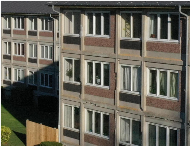
Eksisterende forhold, facade med lukkede partier
