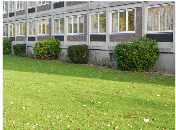
Området foran bygningen omlægges
